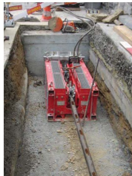
Hydraulische unit in de startput
