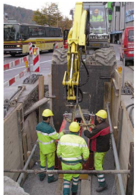
Installatie hydraulische unit
